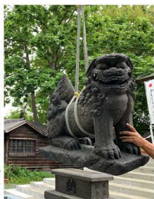
狛犬台座改築施工風景
