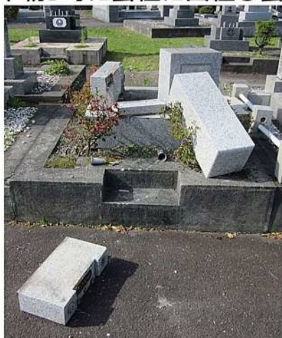
【通路へ倒壊したお墓の被害状況】 前面が通路、背面が空き墓所により前後に地震の揺れが大きく伝わったと思われる。
